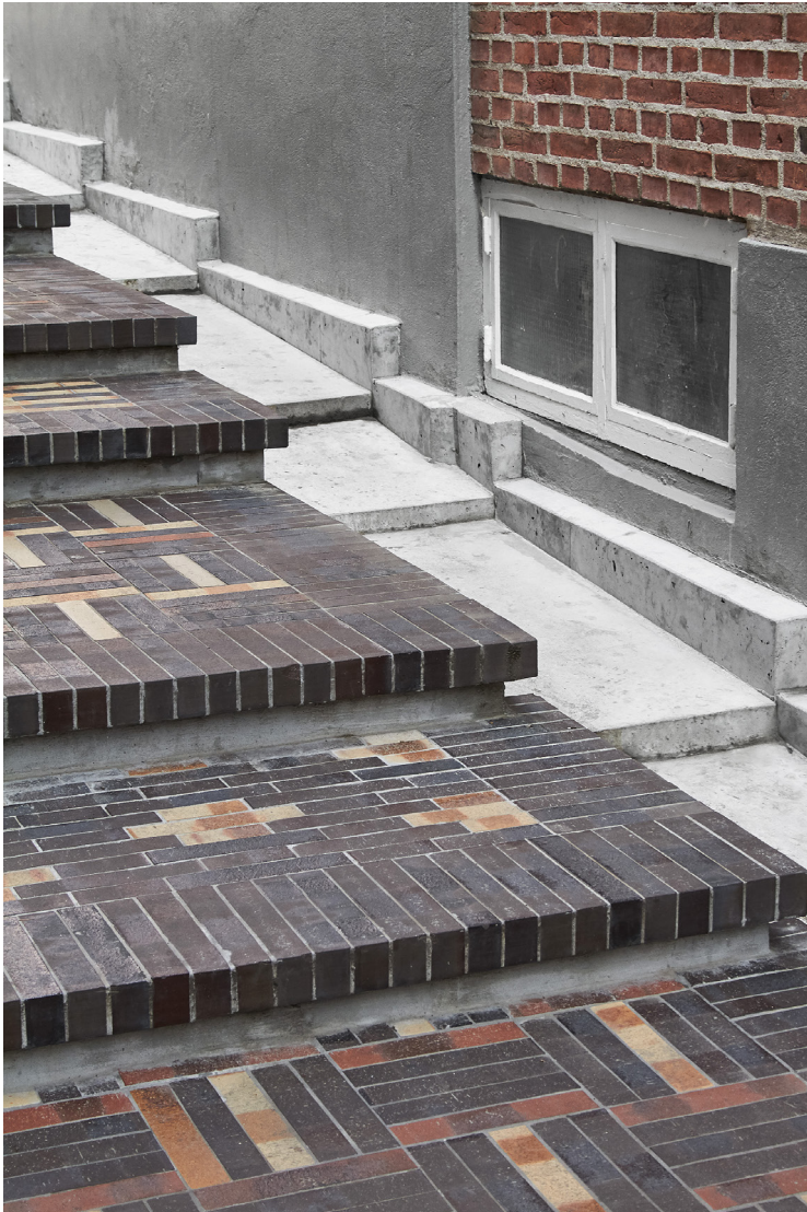
fig. 39 paving, Munkestræde, NOAA architects, Svendborg
