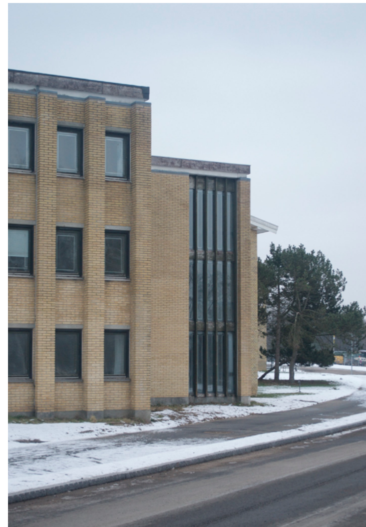
Facade på bygning 154b set fra Perimetervejen
