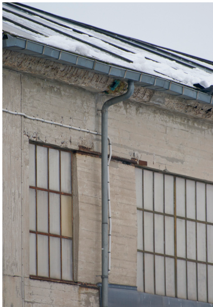
Støbejernsvinduer i Hangar VI
