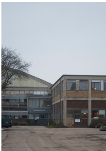
Hangar VI, bygning nr. 104
