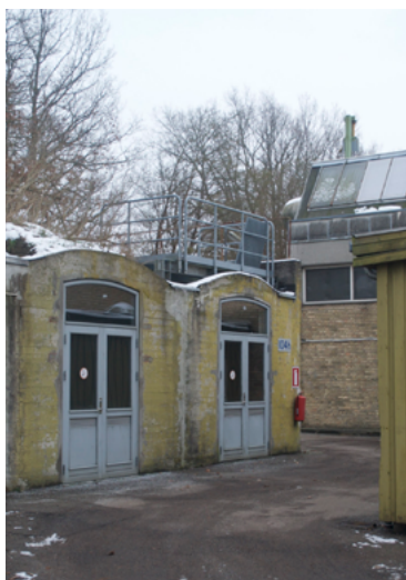
Østlige stræde, Bygning nr. 104h
