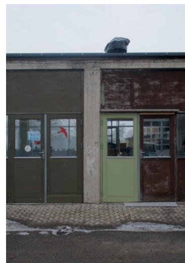
Smedestrædet, Bygning nr. 104f
