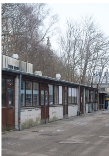
Østlige stræde, Bygning nr. 104k
